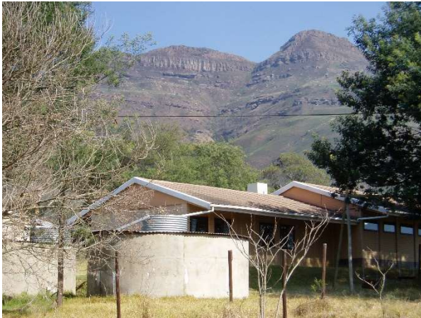
Ein Teil des Therapiezentrums mit Blick auf Bulwer Mountain
